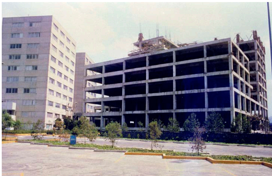
Edificio de Hospitalización en construcción.
